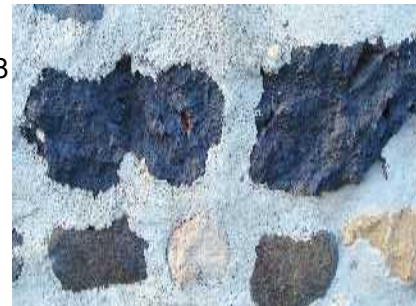
Blocs de basalte brut roche dense, peu taillable (-1,5M.a)
