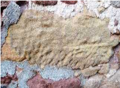
Grès jaune local, bien taillable. Ce bloc a été utilisé par le vent. (-230M.a)
