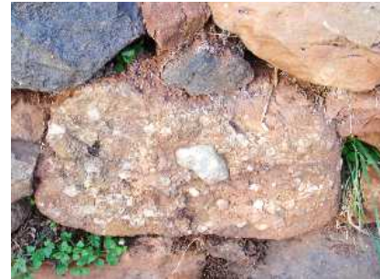
Conglomérat local brut, difficile à tailler. Il est peu présent dans ces vieux murs. (-230M.a)
